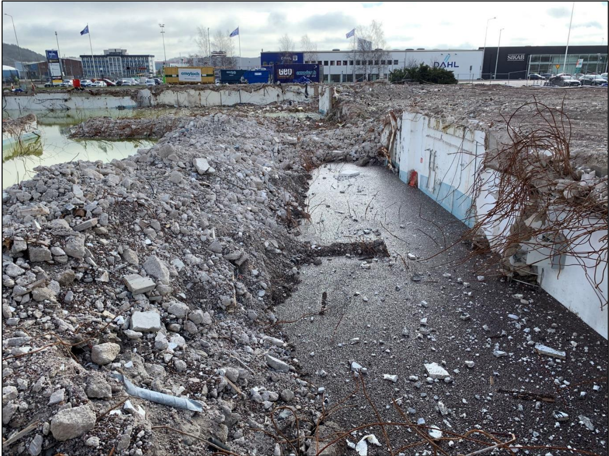
Bild 4.3 Foto taget i samband med rivning av GP-tryckeriet (2019-03-28). Norra delen av området för planerat Polishus, vy från väster mot öster.
